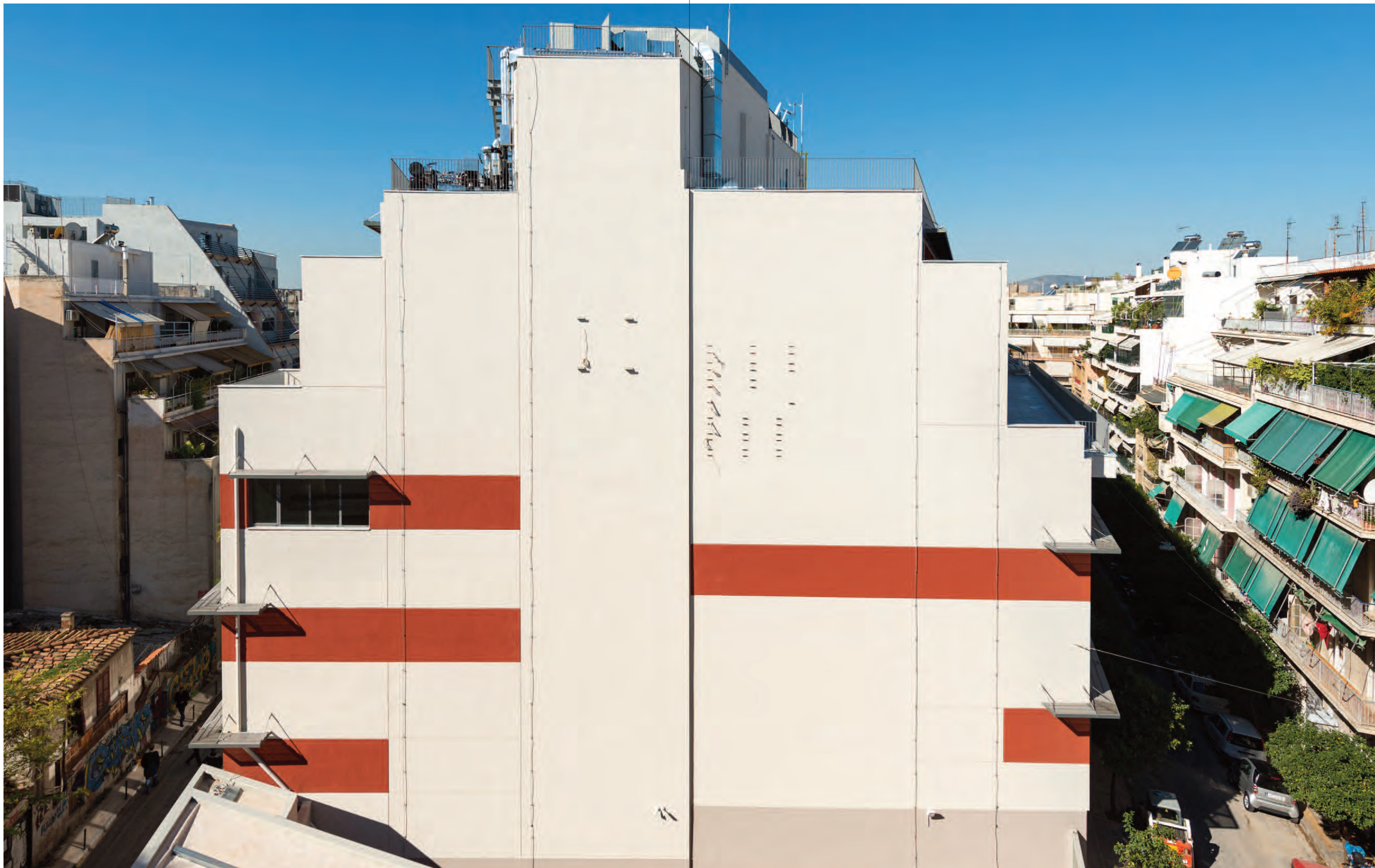
ΟΨΗ ΚΤΗΡΙΟΥ ΑΠΟ ΟΔΟ ΣΠΕΤΣΩΝ
