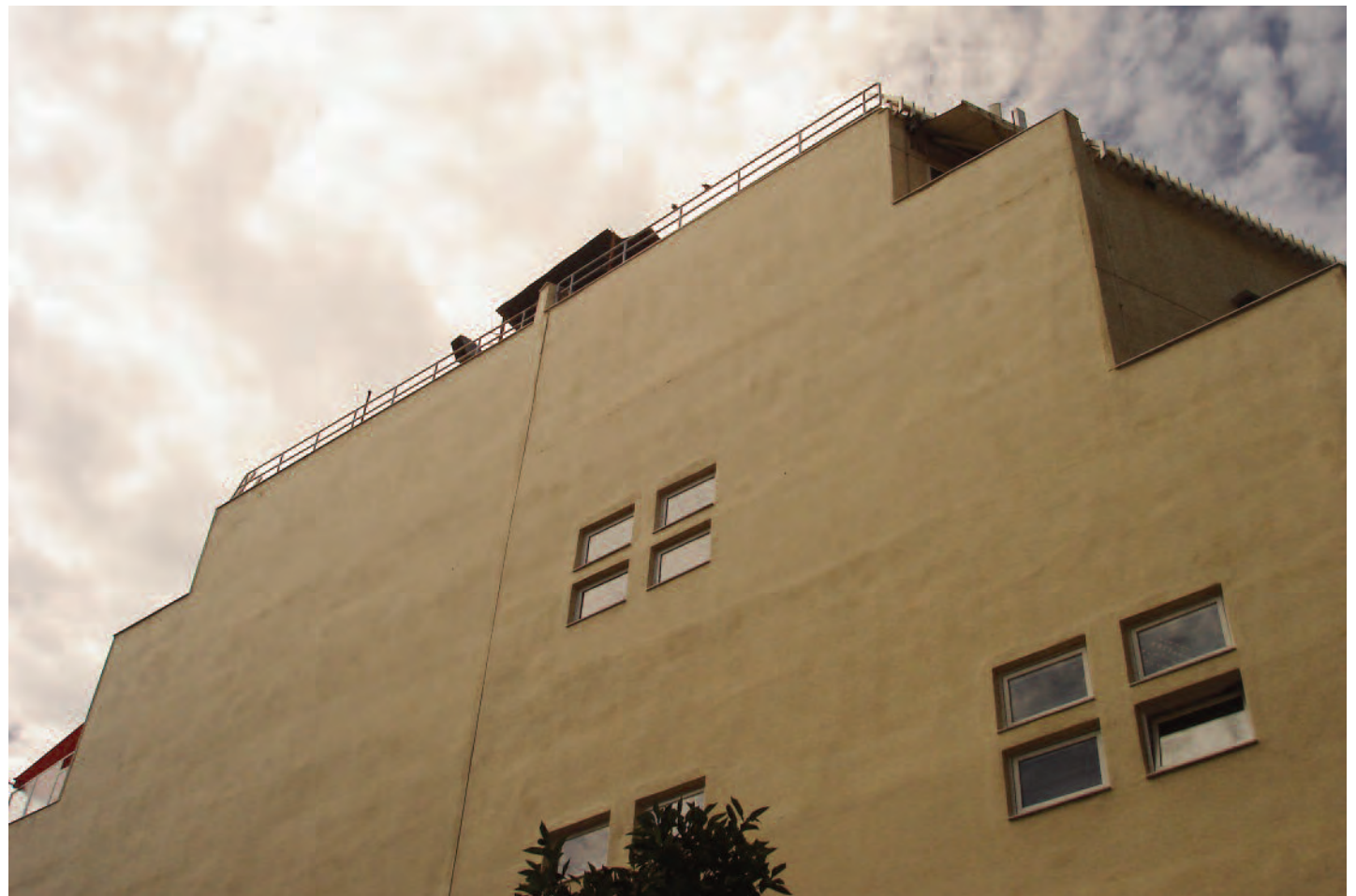
ΟΨΗ ΚΤΗΡΙΟΥ ΑΠΟ ΟΔΟ ΣΠΕΤΣΩΝ
